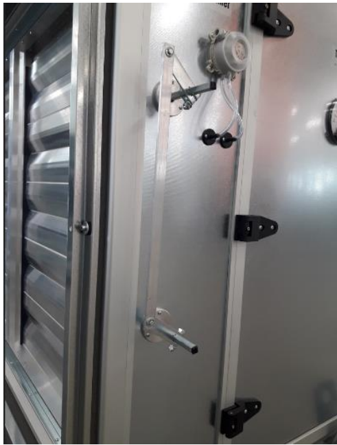
Abb. A – vor Demontage
