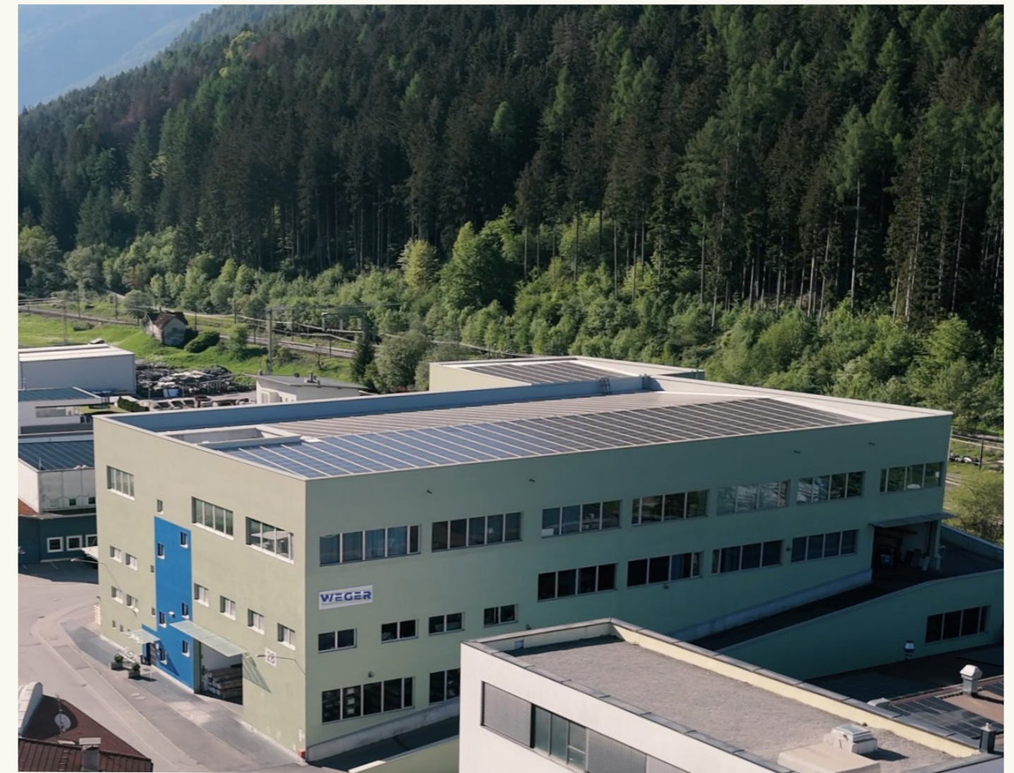
Abb. 6: PV-Anlage Werk Kiens
