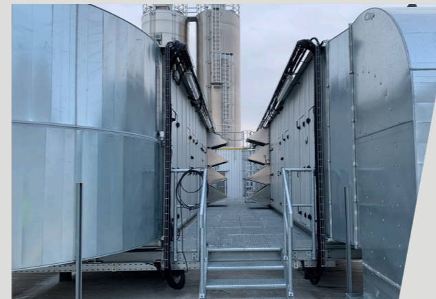
Scala di accesso
