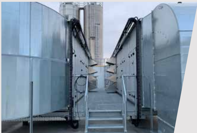
Scala di accesso
