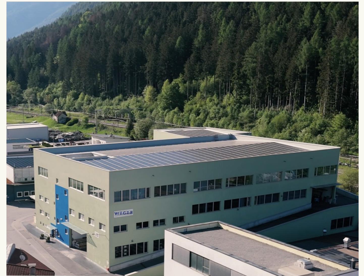
Abb. 6: PV-Anlage Werk Kiens
