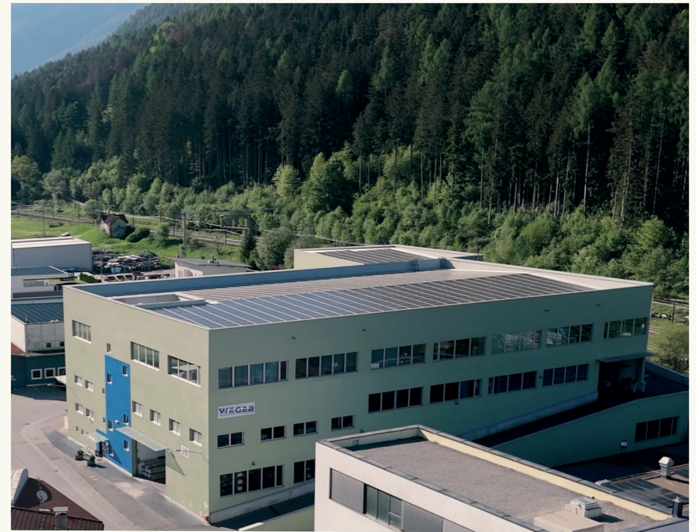
Abb. 6: PV-Anlage Werk Kiens
