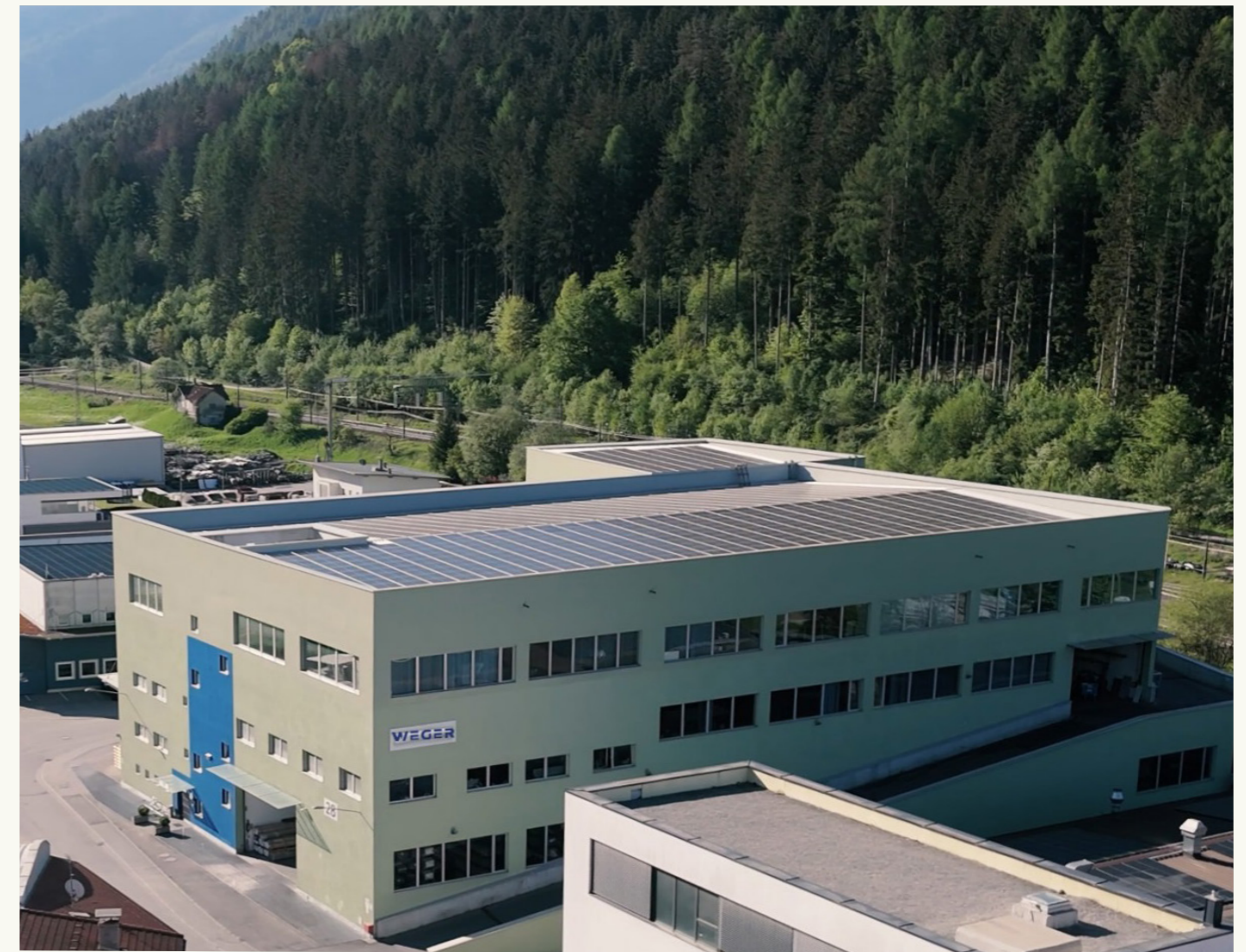
Abb. 6: PV-Anlage Werk Kiens
